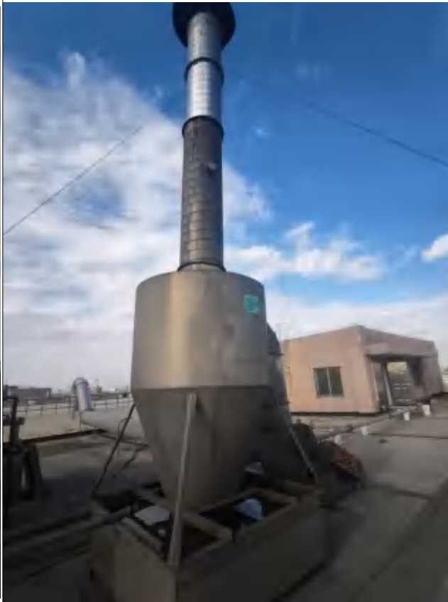
2#抛光粉尘处理设施及排气筒DA003照片
