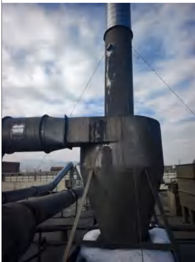
打砂粉尘处理设施及排气筒DA001照片
