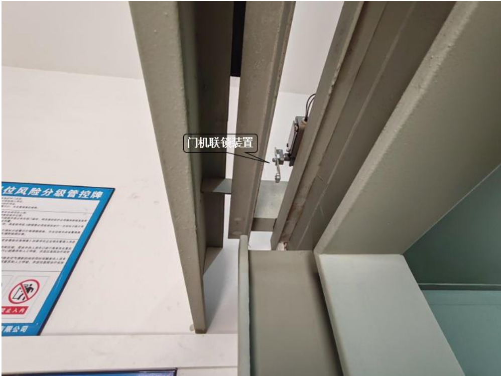
图 3-25 门机联锁装置（行程开关）
