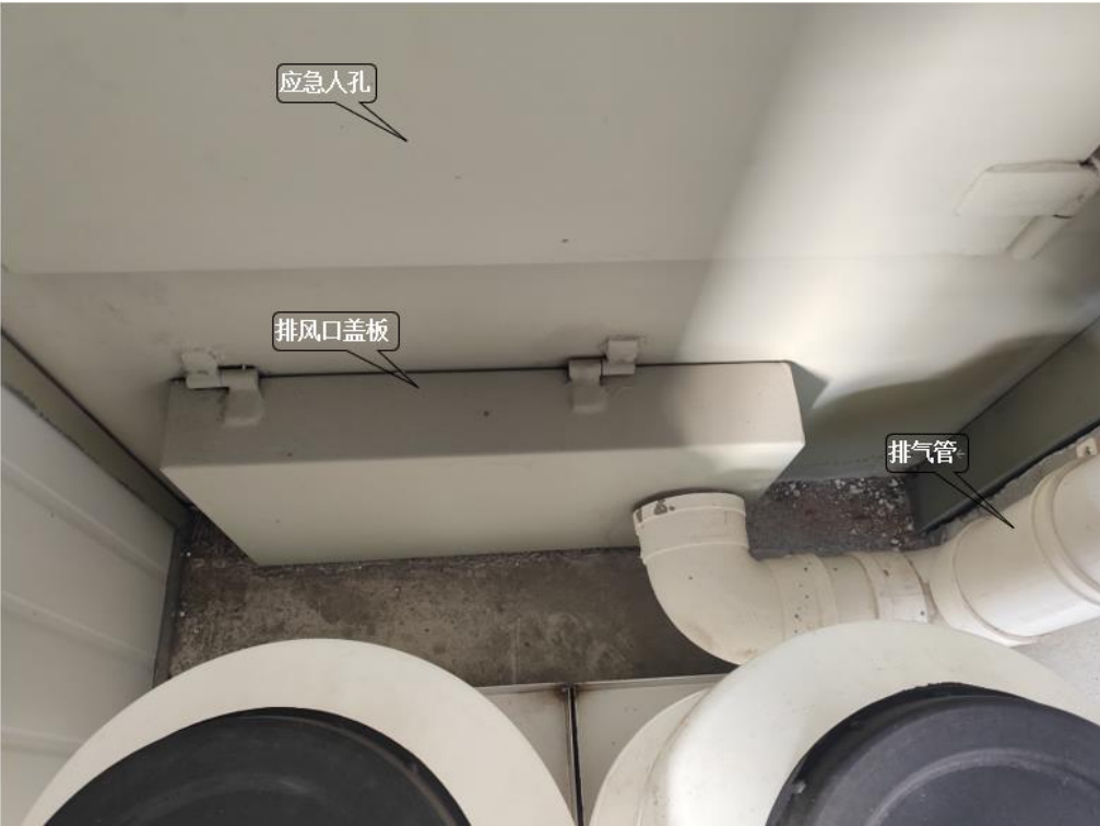
图 3-24 铅房排风口盖板及排气管
