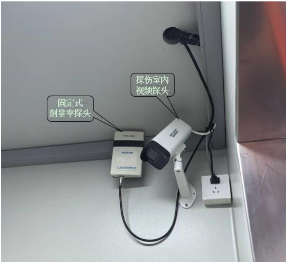
图 3-9 室内监控装置与固定式剂量率探头 BG90GC
