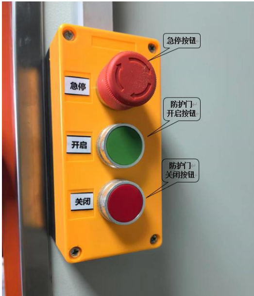
图 3-7 探伤铅房内急停按钮，开、关门开关
