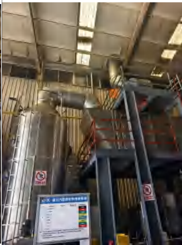
2#燃烧、熔化、浇注、压铸和脱模废气处理设施
