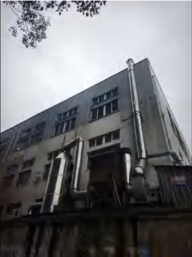
熔化压铸脱模废气处理设施
