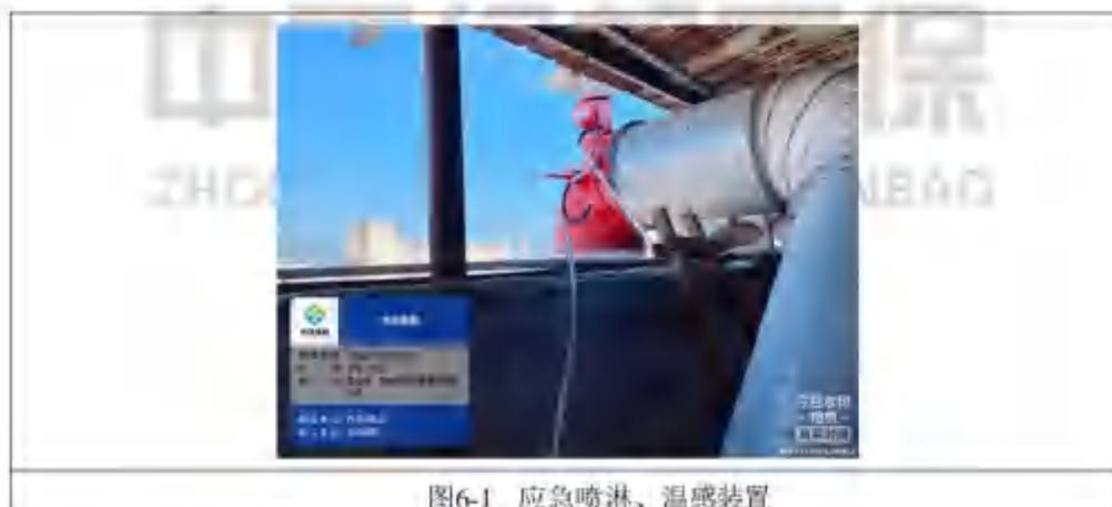
**第八条要求：**喷漆废气须经喷淋塔预净化，喷淋塔应设缺水报警及缺水连锁装置；喷淋塔内部需设自动喷淋系统，当温度超过设置标准时，喷淋自动开启；新建喷淋塔材质原则采
