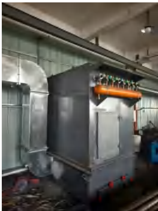
1#抛光打磨粉尘处理设施照片
