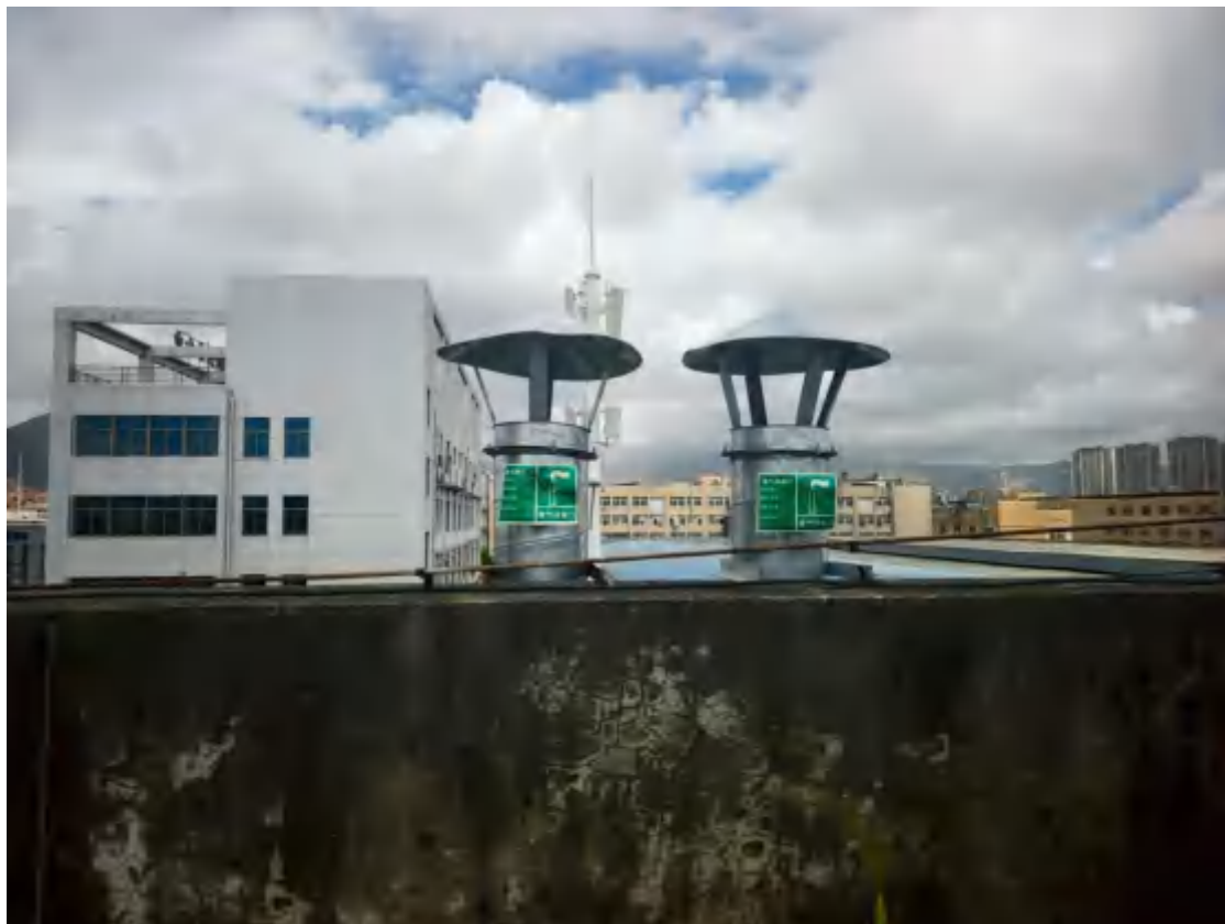
1#抛光打磨粉尘排气筒照片
