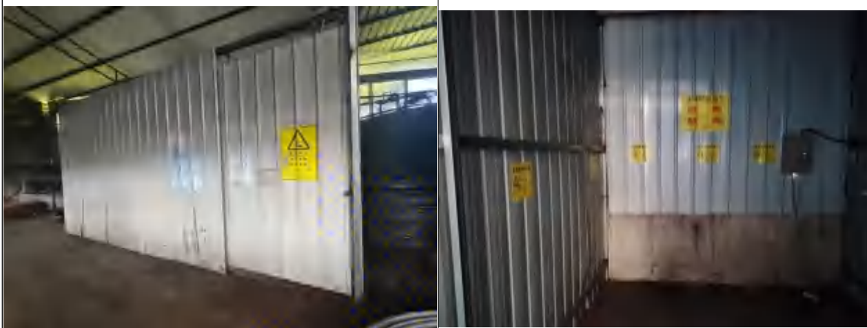
危废仓库内外照片
