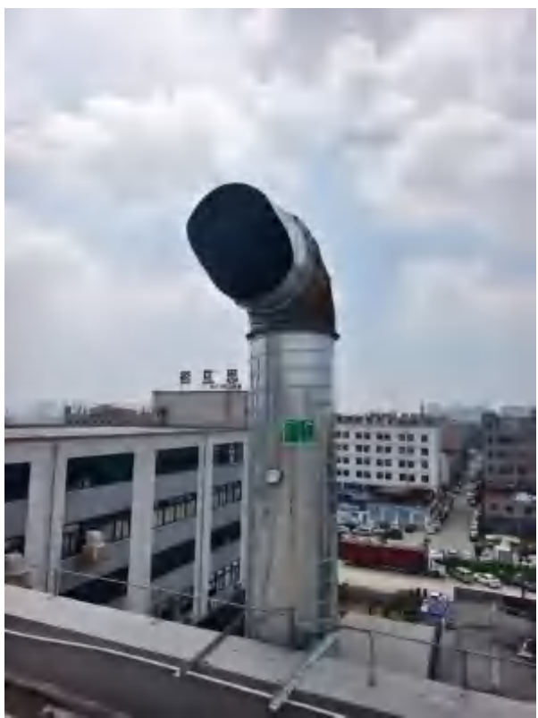
抛光粉尘排放口照片
