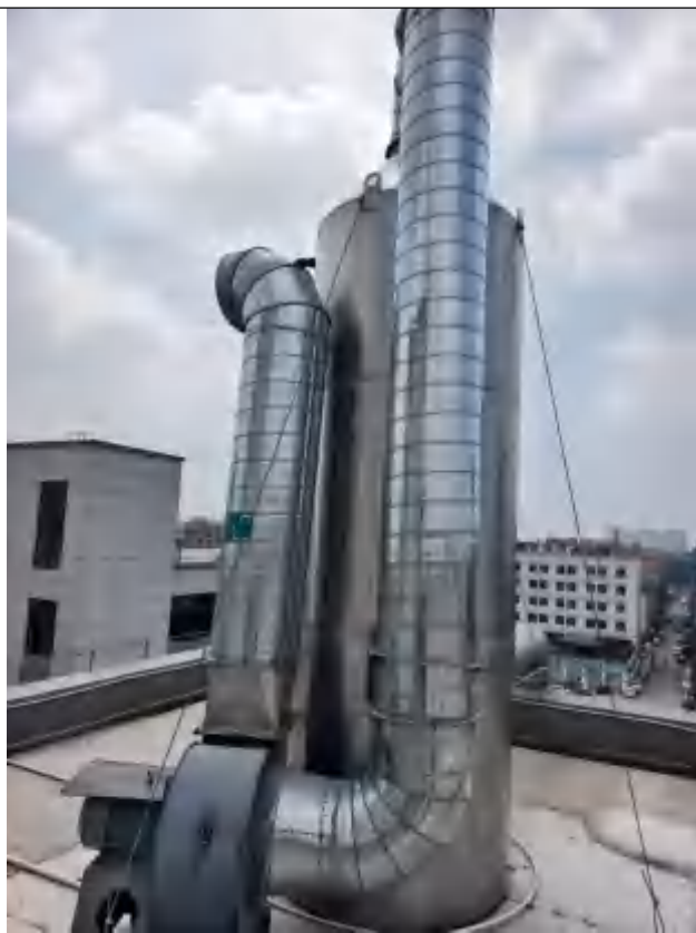
压铸机处理设备及排气筒照片
