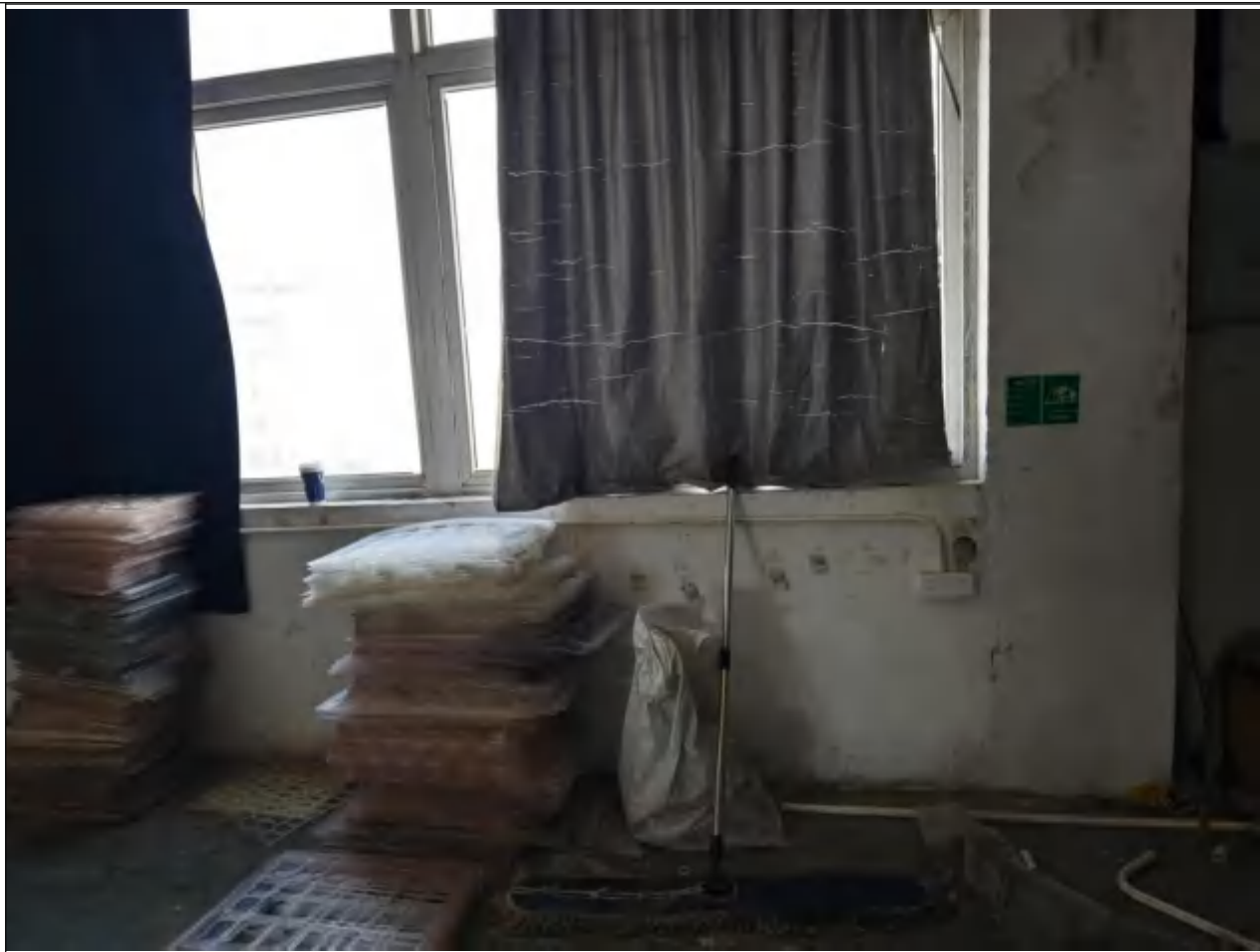
一般固废储存区
