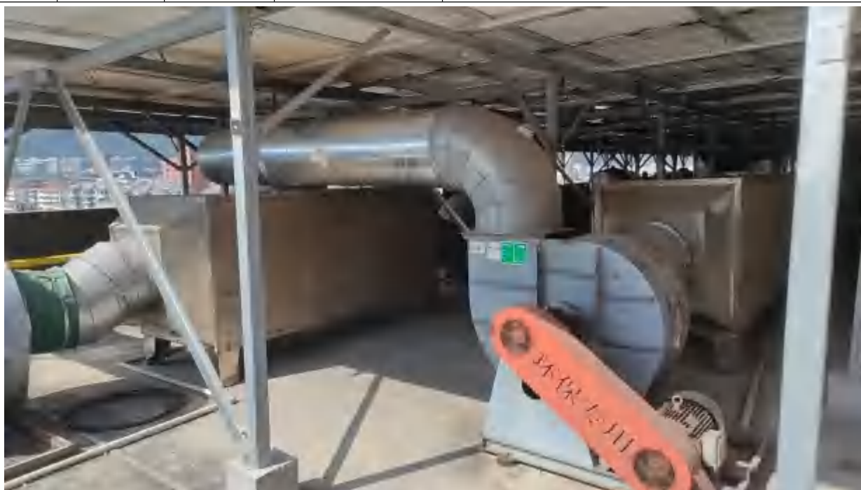
刷胶及烘干、喷光废气处理设施排气筒
