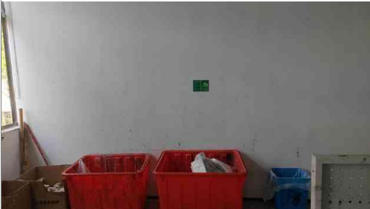
危废仓库内外照片
