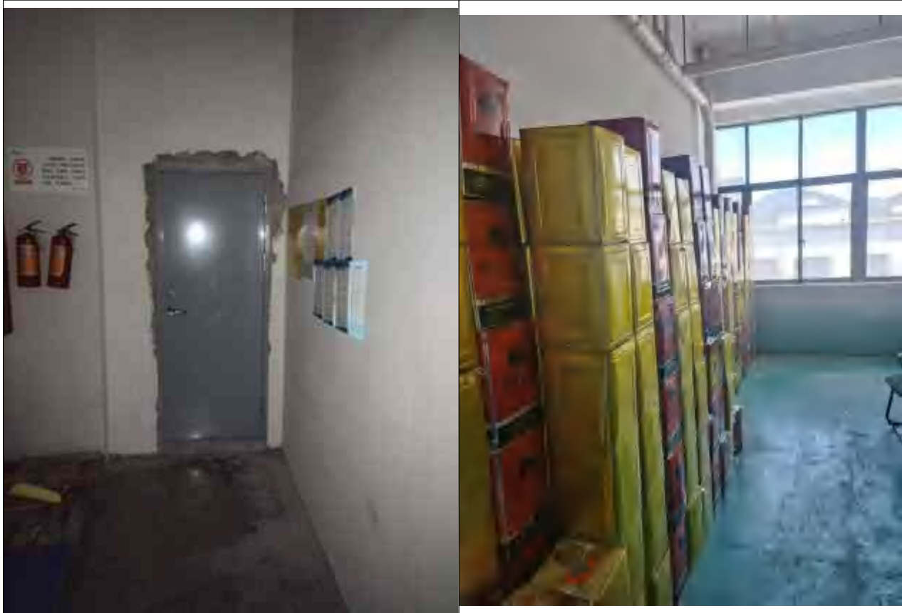
危废仓库内外照片
