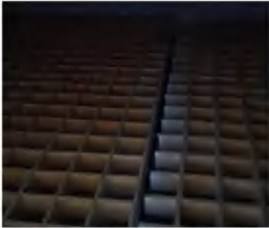
整改后的活性炭吸附箱的内部结构
