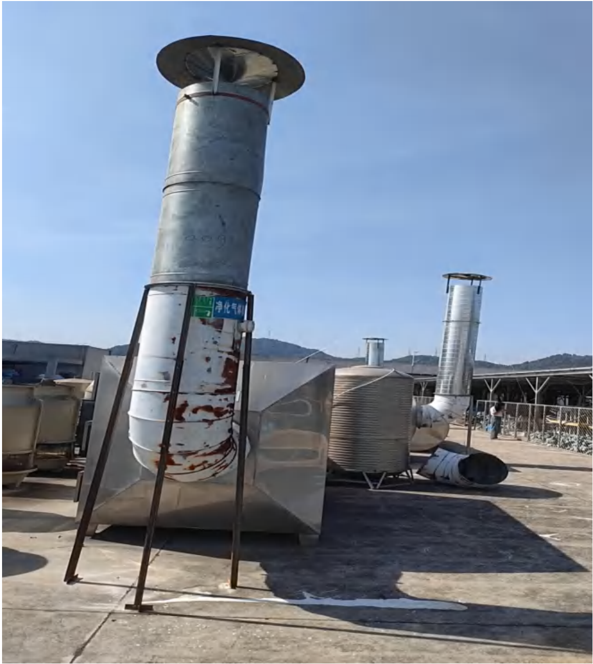
刷胶及烘干、喷光及烘干废气处理设备
