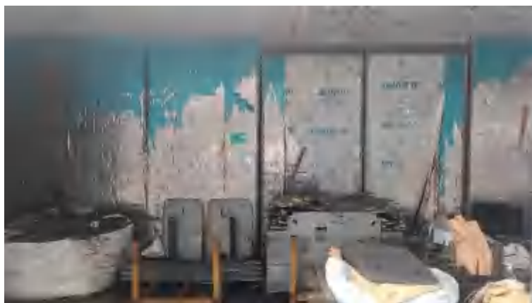
一般固废贮存场所
