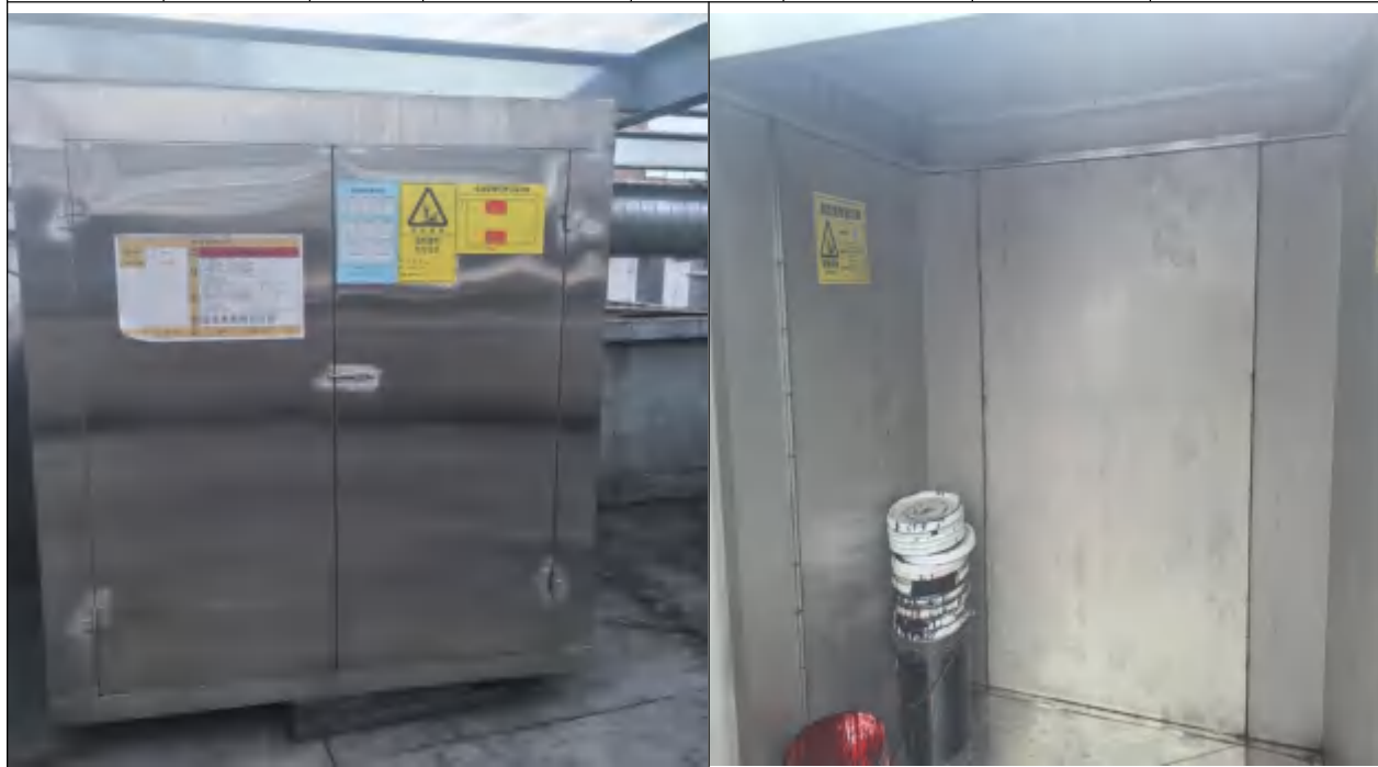
危废仓库内外照片
