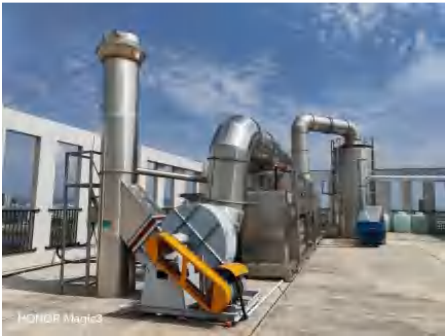
喷漆、烘干废气处理设施
