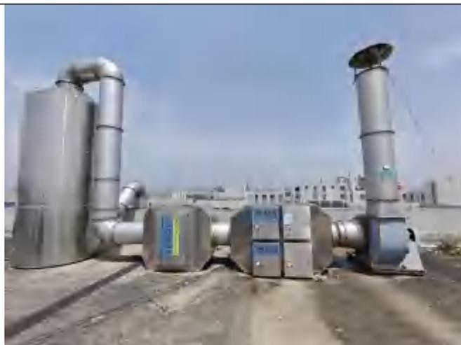
水喷淋塔+初效过滤器吸附+油烟净化器设备
