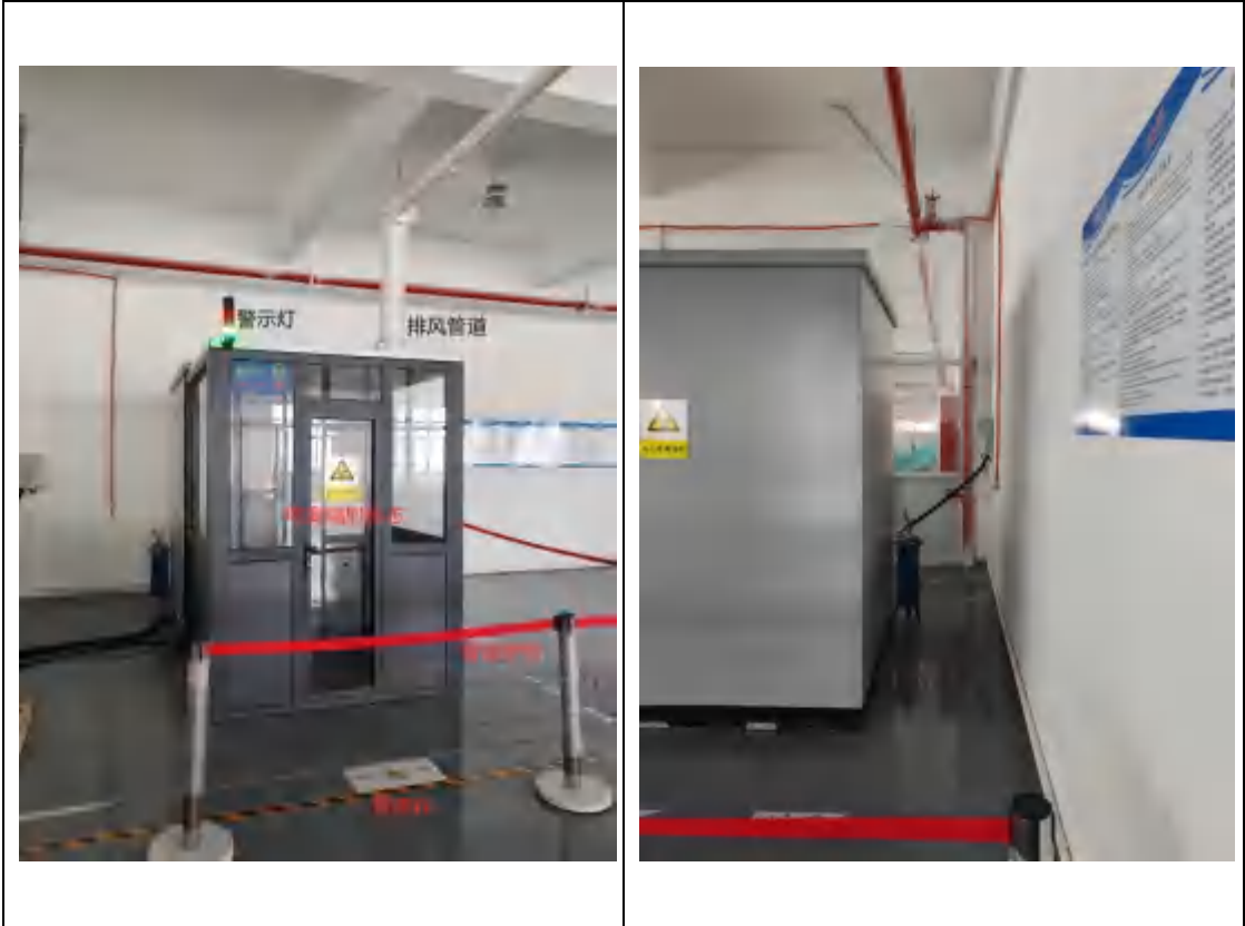
图 6-2 探伤机房北侧
