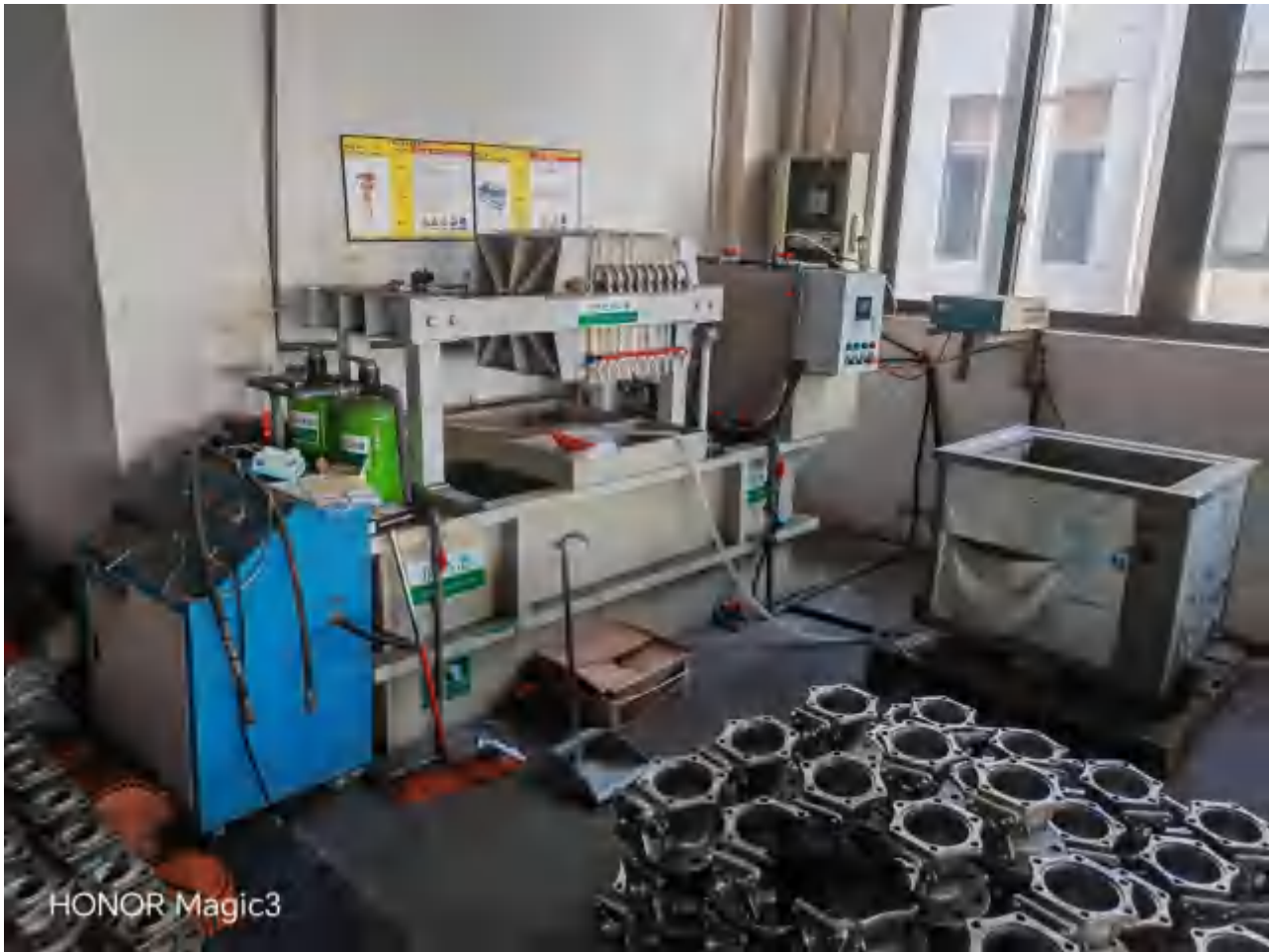
图3-2 废水处理设备照片
