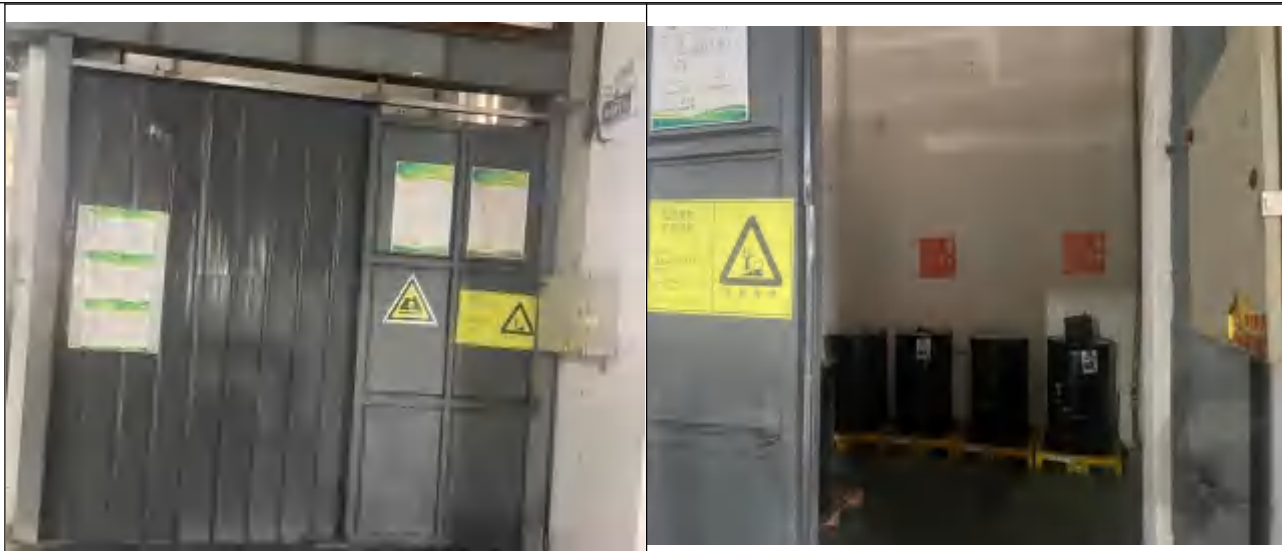
危废仓库内外照片
