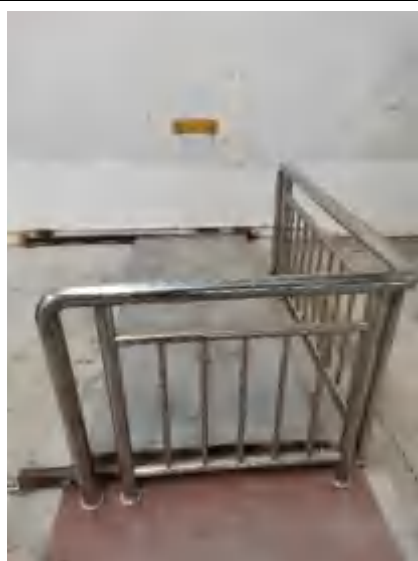
图6-36 七#机房北侧地坑出入口
