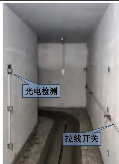
图6-21 七#机房一层迷道（2）
