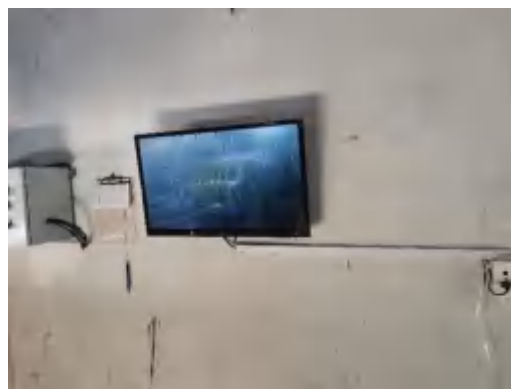
图6-33 操作室内视频监控2
