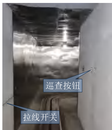
图6-22 七#机房一层迷道（3）
