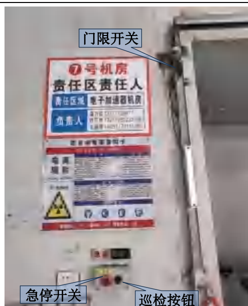
图6-34 七#机房一层工件入口门
