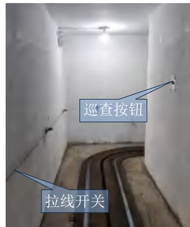
图6-23 七#机房一层迷道（4）
