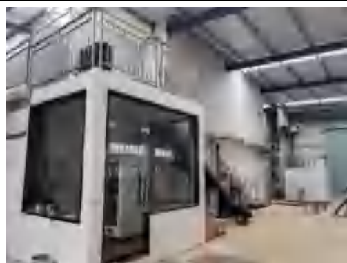
图6-30 七号机房北侧
