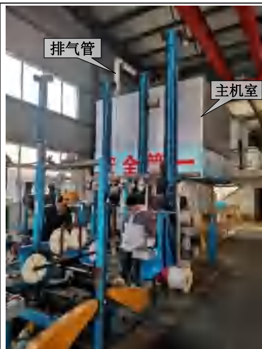
图6-9 自屏蔽电子加速器东侧操作区
