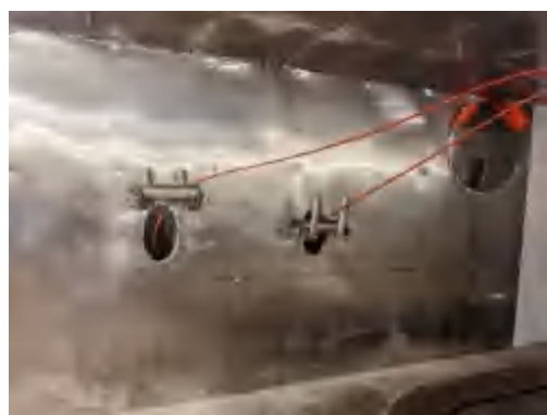
图6-30 辐照厅内进出线孔
