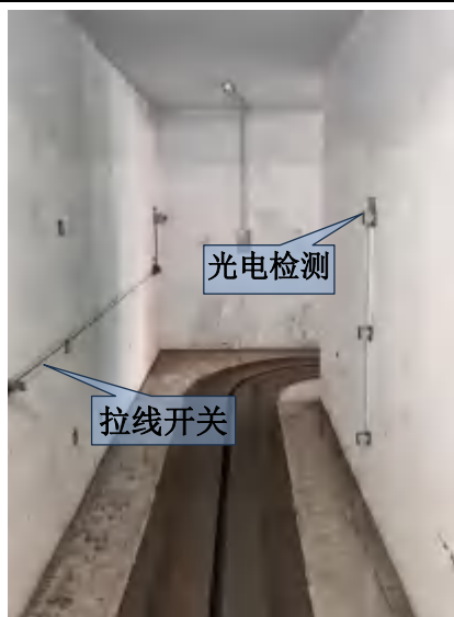
图6-20 七#机房一层迷道（1）
