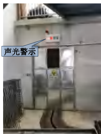
图6-40 七号机房南侧推车出入口
