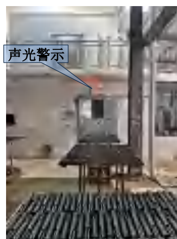
图6-41 七号机房北侧推车出入口
