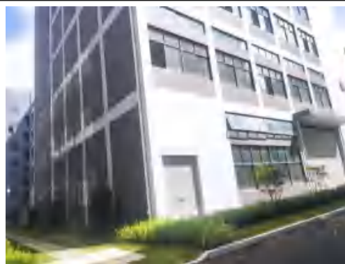
项目西南侧（2 栋）
