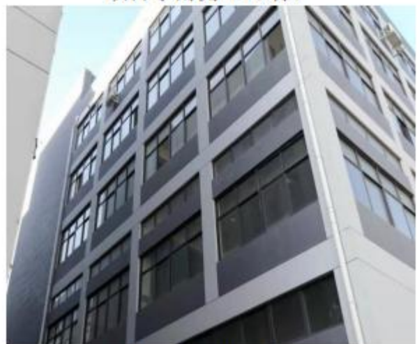
项目西南侧（24 栋）
