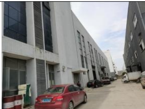
项目西南侧（④号位置）
