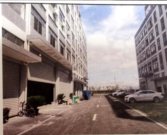
项目东南侧（雁霄路）
