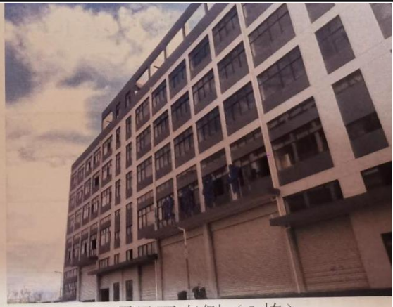
项目西南侧（5 栋）
