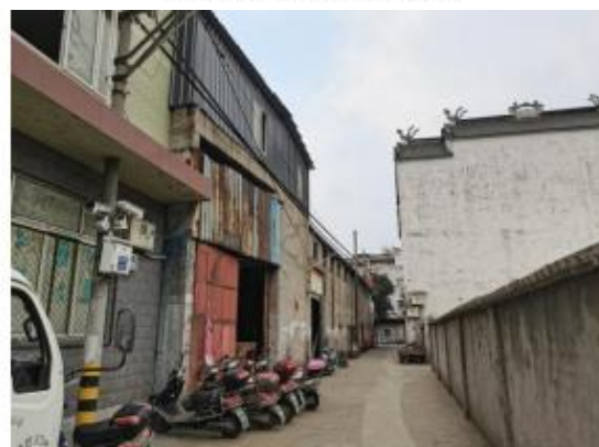
项目西南侧（④号位置）
