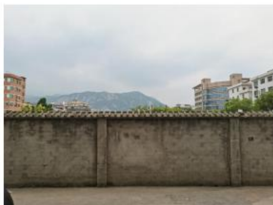
项目西北侧（①号位置）
